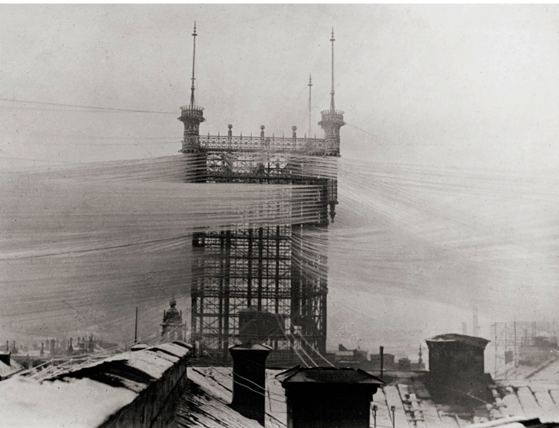
Rimfrostbelupna telefonledningar i telefontornet på Brunkebergstorg, Stockholm, vintern 1890. Foto: Tekniska museet.
