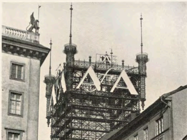
Bild 5 a. Dagsljusbild av bokstavsskylt med öppen lyskanal. På grund av skyltens dimensioner (höjden på »AfA» är 7 m., bögra stapeln på »A» 1,5 m. bred) är den läsbar på mycket stora avstånd.
