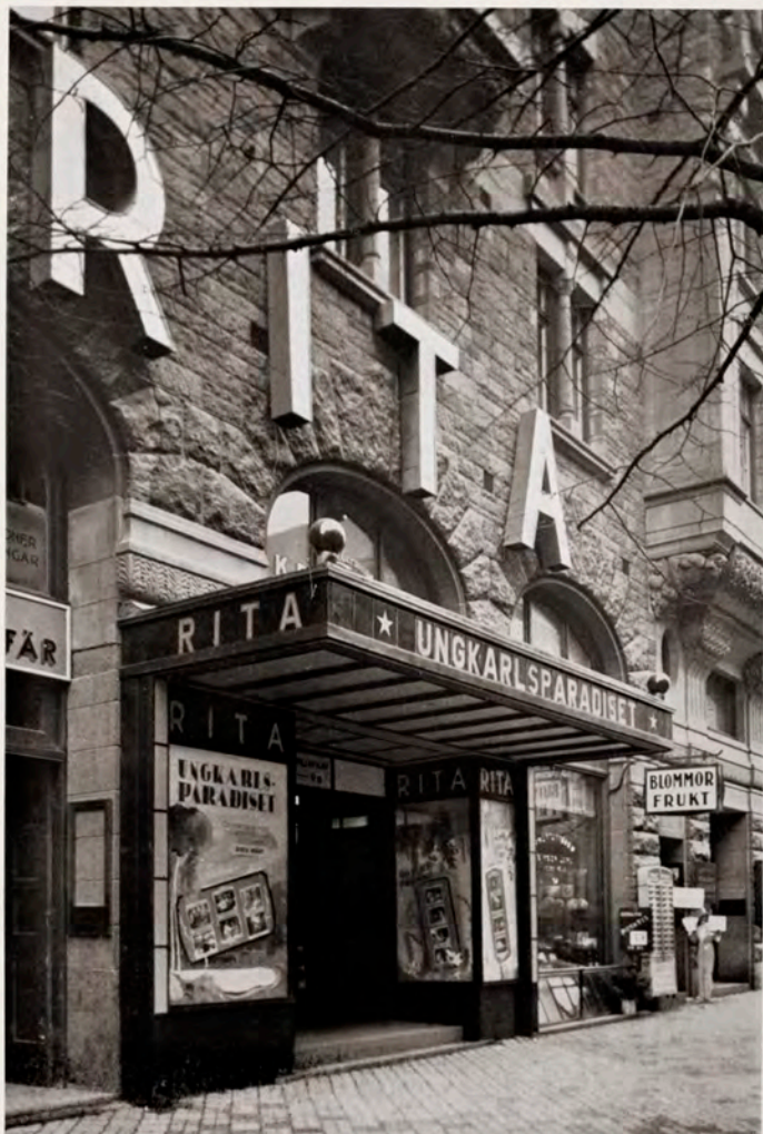
Bild 12 b. Dagsbild av samma skylt. Placeringen av de stora skyltbokstäverna är här annan än på bild 12 a, där dessa äro monterade på baldakinens framkant. En flyttning måste utföras på grund av att bokstäverna vid förutvarande placering skymde utsikten för den över biografen belägna lokalen.
