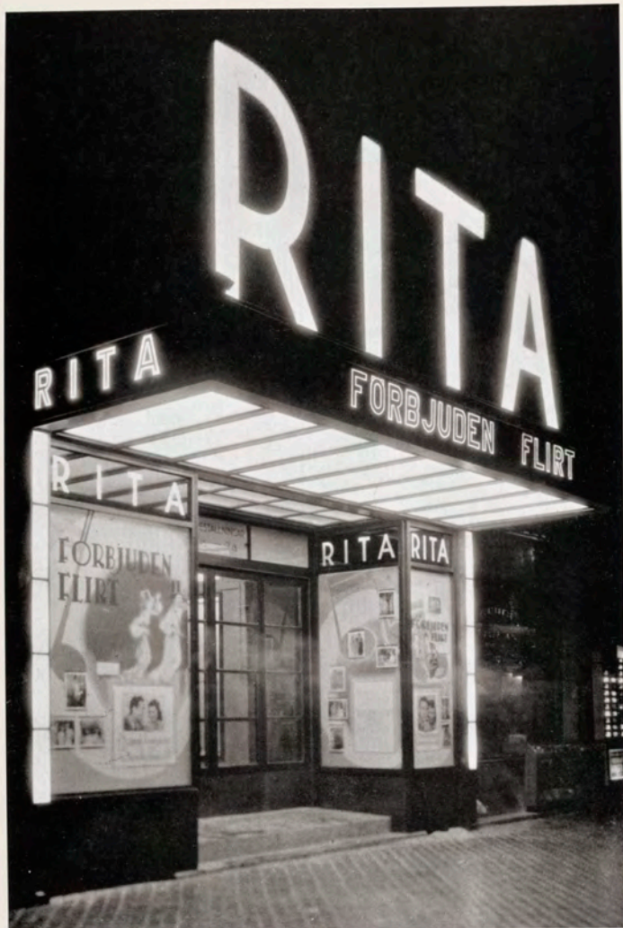
Fig. 12 a. Ljusskylt med opalglasövertäckt lyskanal (RITA). Programskyltar med utbytbara bokstäver av perforerade plåtar med indirekt belyst bakgrund. Baldakinens tak utbildat som transparent.
