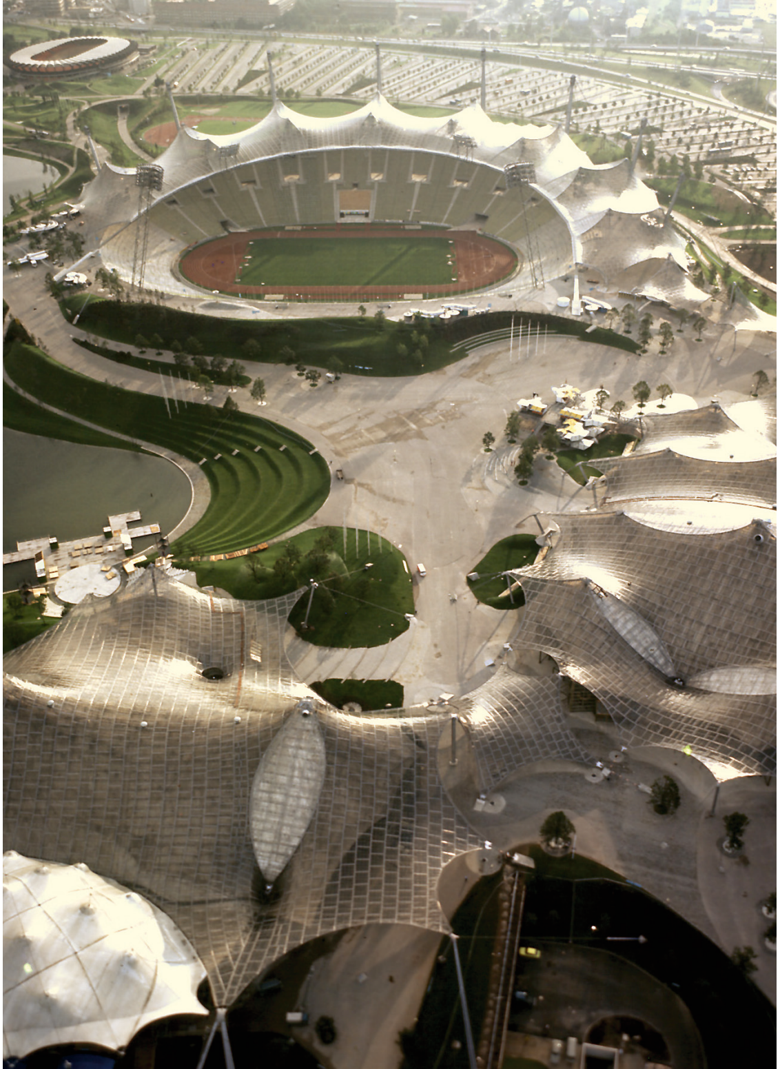
[Fig. 6] Efter andra världskriget förkastades nazi-periodens monumentalitet. När Olympiastadion byggdes i München 1972 valde man avsiktligt att bygga ett idrottstempel med planerat begränsad livslängd och ett slags "visuell platthet" som föreföll vara motsatsen till det storvulna.
